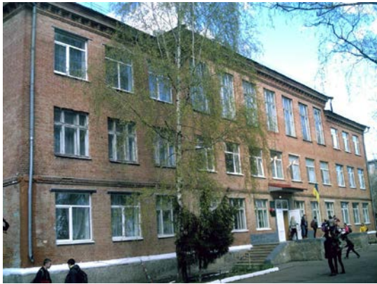
Рис. 3. Загальний вигляд головного фасаду обстежуваної будівлі
