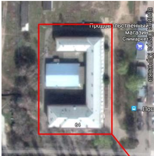
Рис. 2. Загальний вигляд контуру обстежуваної будівлі
