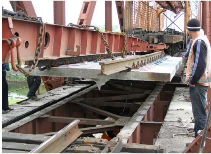
Рис. 1. Укладання мостового полотна на плитах БМП
