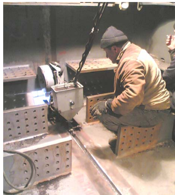
Рис. 4. Автоматическая сварка под флюсом стыковых соединений поясов арки
