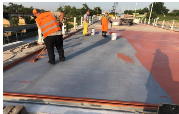
Рис. 2. Аварійно-відновлювальні роботи на мості на автомобільній дорозі М-06 Київ-Чоп км 831+711 через р. Тису, Закарпатська область
