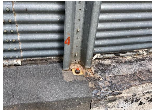
Рис. 2. Приклад маркування постійних точок вимірювання осідань фундаменту силосів
