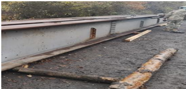
Рис. 2. Застосування зварних широкополочних двотаврових балок типу МА L_p=18,53 м із сталі 15ХСНД
