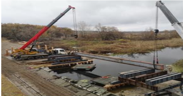
Рис. 1. Застосування інвентарних конструкцій надбудов, опор «ИМИ-60»
